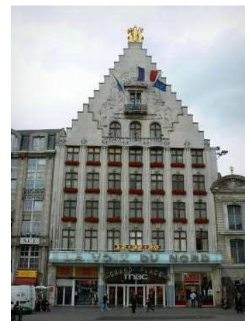
Façade flamande du bâtiment de la Voix du Nord, Lille
